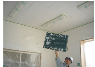
事務所養生状況
