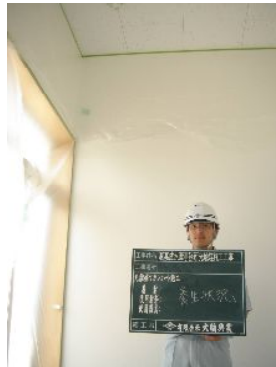
玄関養生状況
